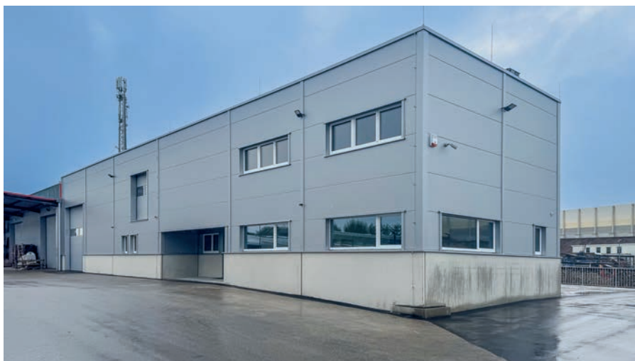
Das neue Bauhofgebäude in der Mühlgasse mit Lagerhalle und Sozialräumen.
